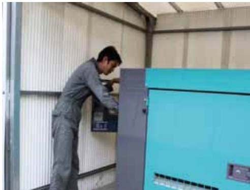
▲停電時に使用する発電機をチェックします。頻繁に停電が起こるわけではありませんが、いざという時のためにチェックは欠かせません。
