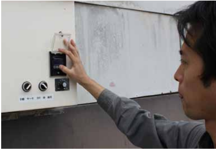
▲鶏舎の温度管理は特に重要です。右写真に写っている大きなファンは、鶏舎の温度を一定に保つ様に設定されているそうです。状況に応じて、設定温度を変えて鶏舎内の環境を調整します。
