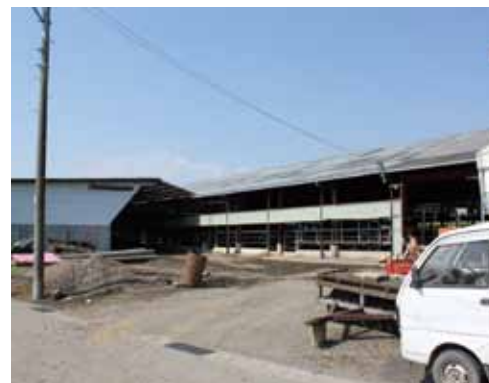
▲大半の牛が飼育されている牛舎。実は廃鉄骨で建築したそうです。とてもきれいに手入れがされていました。
